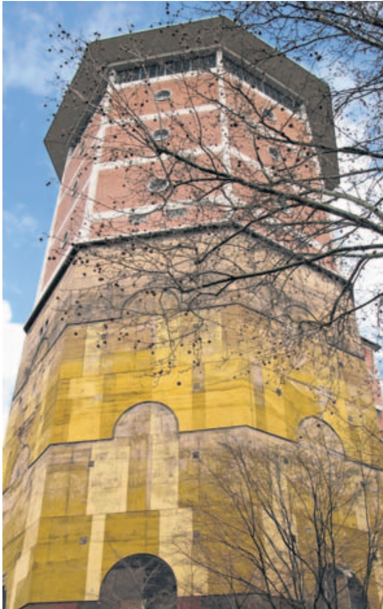
Beeindruckendes Bauwerk: Auf dem Bunker in der Rollesstraße ist noch ein Wasserturm untergebracht. BILD: BUR
